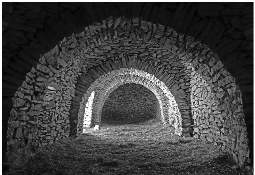
Innenraum der bergerie mit 4 Kuppeln, abgetrennt durch Keilsteinbögen, die am Boden beginnen.
