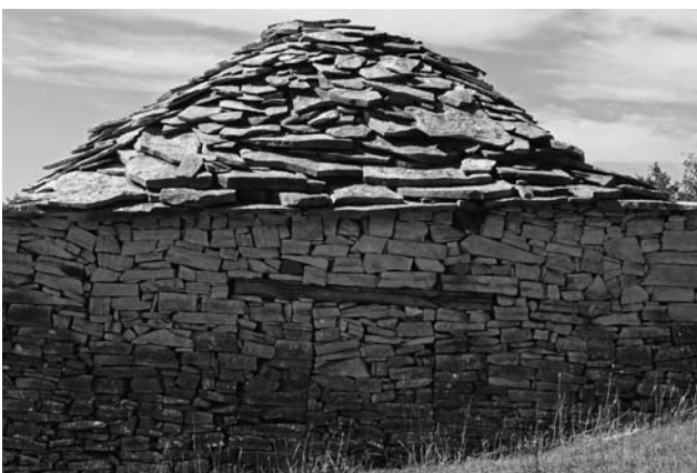
Auf der Rückseite des Stalles wurde eine Türöffnung zugemauert.
