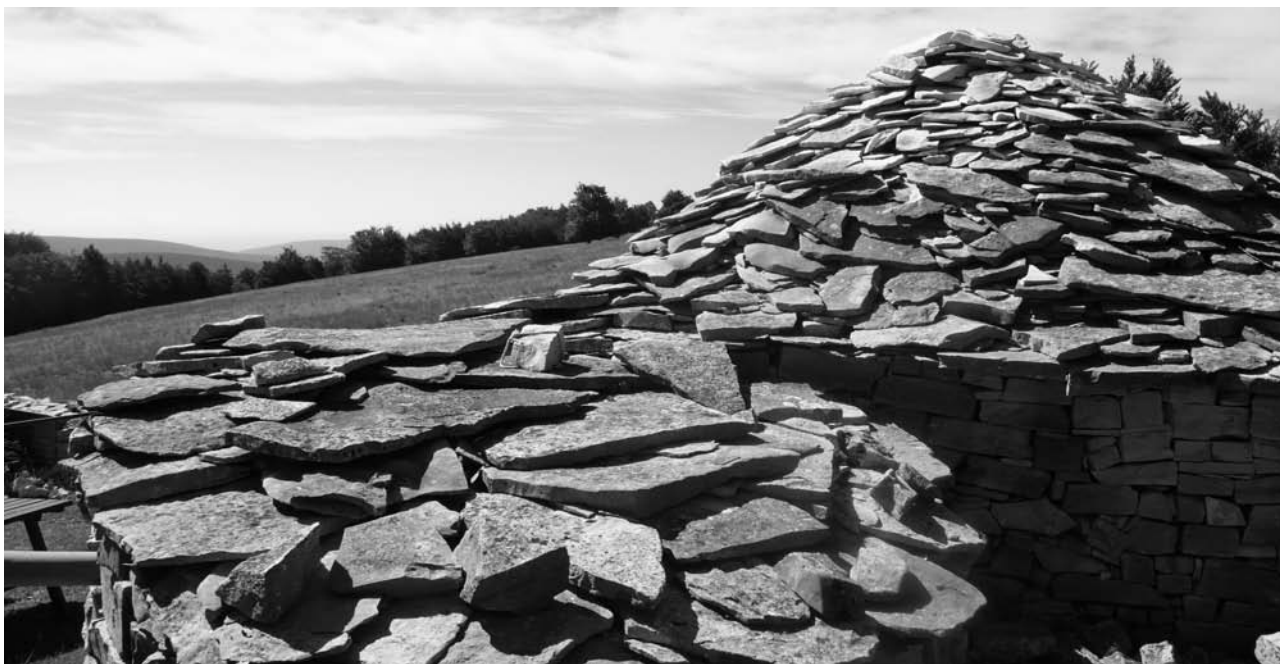
Große flache, nach außen gesenkte Steinplatten bedecken die Dächer, hier die Hirtenhütte und die Zisterne im Vordergrund.
