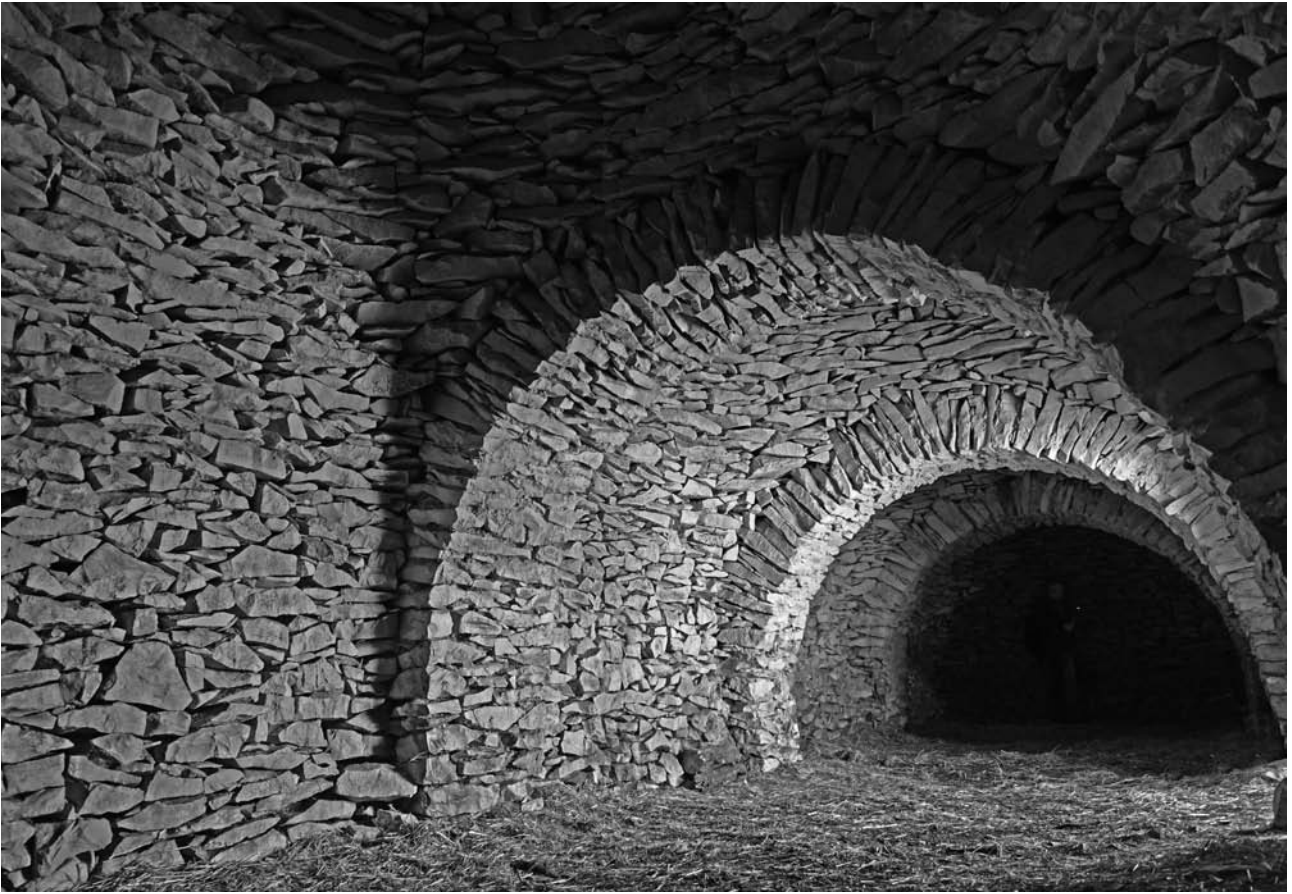
Innenraum der bergerie mit 4 Kuppeln, abgetrennt durch Keilsteinbögen, die am Boden beginnen.
