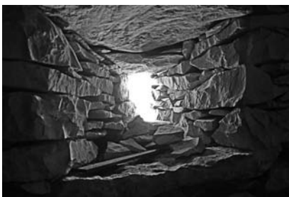
Innenraum der bergerie mit 4 Kuppeln, abgetrennt durch Keilsteinbögen, die am Boden beginnen.
