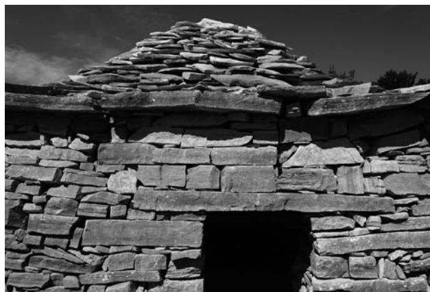
Regelmäßig bearbeitete Steinblöcke um den Eingang der Hütte.
