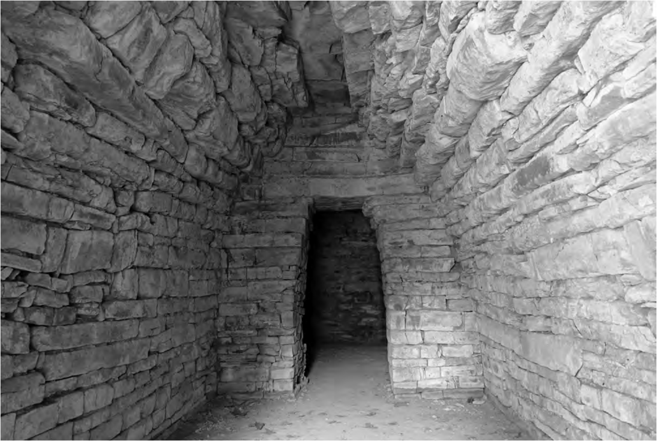
Tombe A. Die Wände sind komplett aus dem regionalen Sandstein geschichtet. Innen formen nur wenig bearbeitete unregelmäßige Steine gut erhaltene Kraggewölbe. Nur über den Eingängen sind größere Steinbalken eingebaut.
