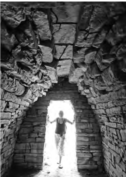
Tombe A. Die Wände sind komplett aus dem regionalen Sandstein geschichtet. Innen formen nur wenig bearbeitete unregelmäßige Steine gut erhaltene Kraggewölbe. Nur über den Eingängen sind größere Steinbalken eingebaut.
