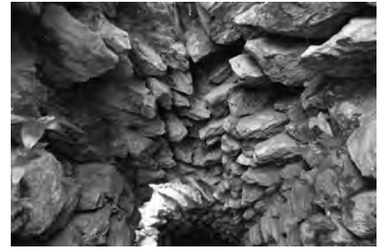
Abwasserkanäle der alten Stadt Vetulonia mit Abdeckung, die wie eine Radial-Bogen-konstruktion aussieht.
