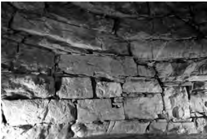
Perfekt erhaltene Kragkuppel der Tomba della Montagnola mit verputzter Mittelsäule. Zweischichtiger Durchgang zur Grabkammer aus gehauenen und nach oben abgerundeten Sandsteinblöcken.
