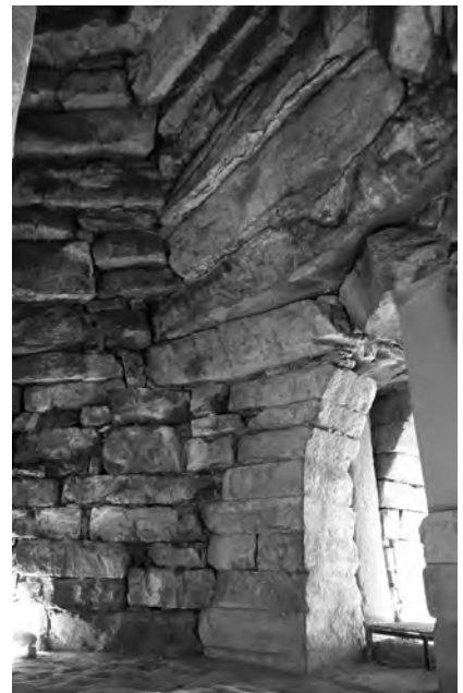
Perfekt erhaltene Kragkuppel der Tomba della Montagnola mit verputzter Mittelsäule. Zweischichtiger Durchgang zur Grabkammer aus gehauenen und nach oben abgerundeten Sandsteinblöcken.
