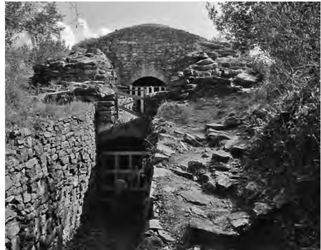
Foto 1988. Heute sind beide Zugänge über neu angelegte Rampen erreichbar.
