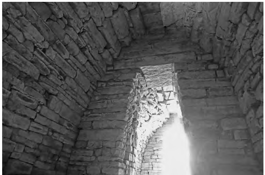
Tombe A. Die Wände sind komplett aus dem regionalen Sandstein geschichtet. Innen formen nur wenig bearbeitete unregelmäßige Steine gut erhaltene Kraggewölbe. Nur über den Eingängen sind größere Steinbalken eingebaut.
