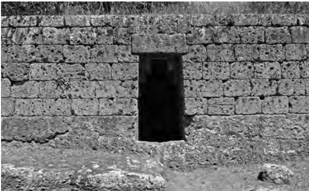
Mauerwerk aus Tuffsteinblöcken in Anpassung an den vorhandenen Felsboden.
