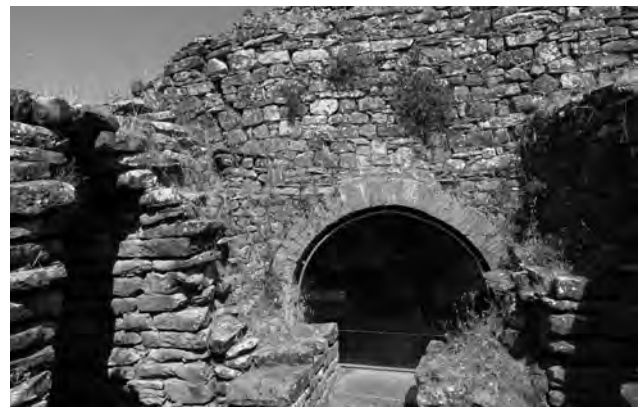
Links unten: Seitenkammer mit Kraggewölbe.
