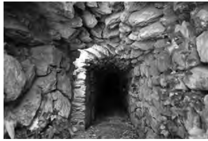
Abwasserkanäle der alten Stadt Vetulonia mit Abdeckung, die wie eine Radial-Bogen-konstruktion aussieht.
