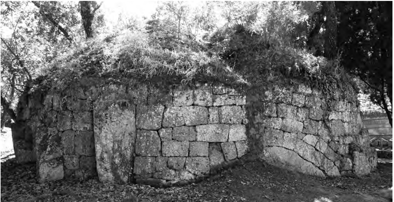
Mauerwerk aus Tuffsteinblöcken in Anpassung an den vorhandenen Felsboden.
