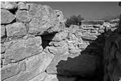
Verschlussplatte vor dem Eingang
