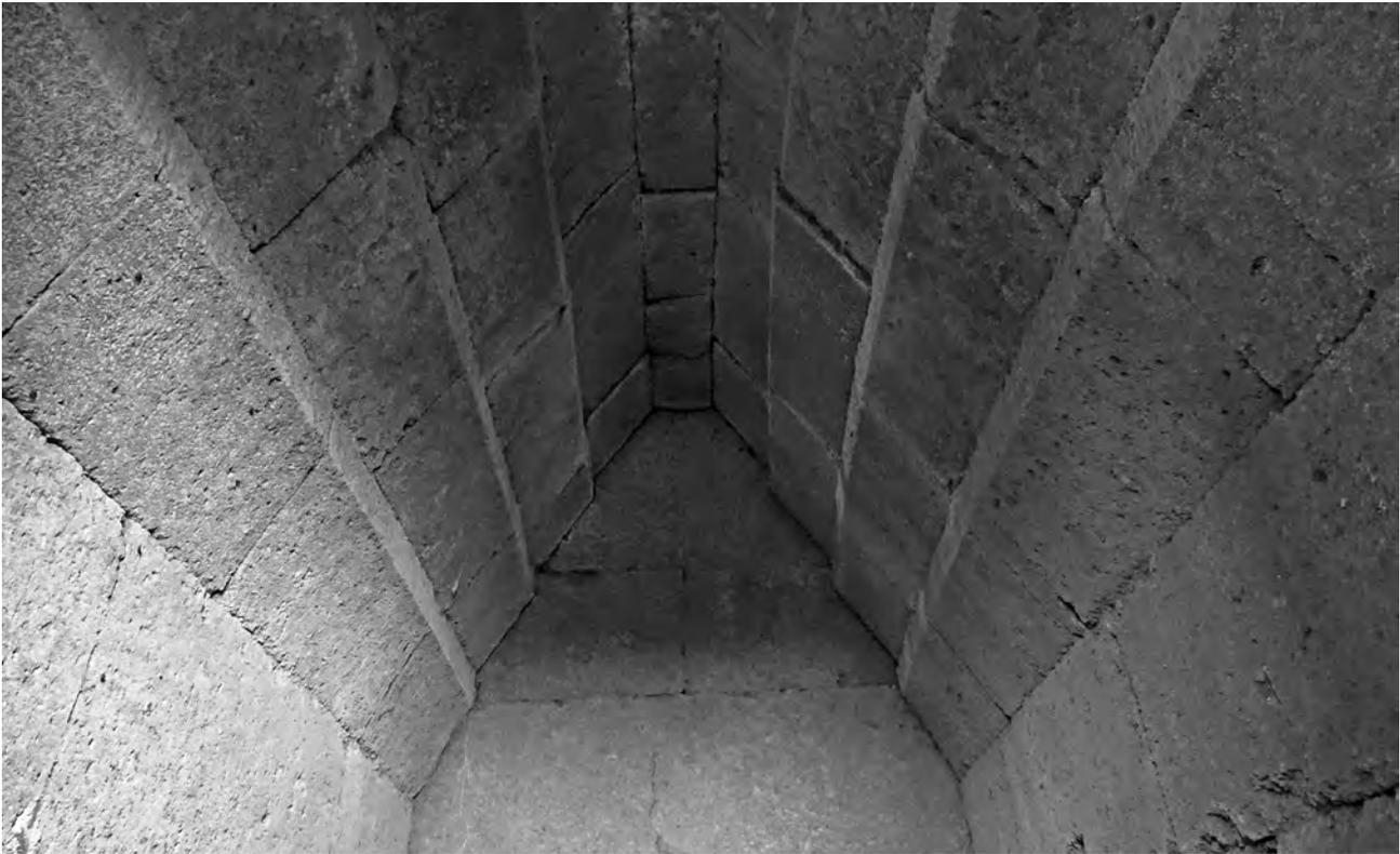
2 - 3 Stufen führen in die Grabkammern hinunter. Diese sind 3 - 3,75 m lang, ca. 3 m breit und 2,60 - 3,30 m hoch. Meist sind 2 Totenbänke vorhanden. Die Steine der Innenwände und des Kraggewölbes sind sorgfältig behauen. Das überkragende Prinzip wird durch eine obere Schräge der einzelnen Schichten fast symbolisch angedeutet. Bis auf die
