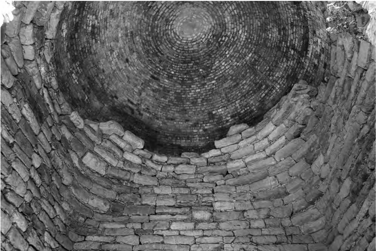
Die obere Kuppelwölbung war nach steilem Anstieg wohl zu flach geschlossen worden, was möglicherweise den späteren Einsturz der Kragkuppel zur Folge hatte. Unten steht noch die Mittelsäule aus Granit; man erkennt Reste des Mauerwerks der unteren Kammer und von Totenlagern.
