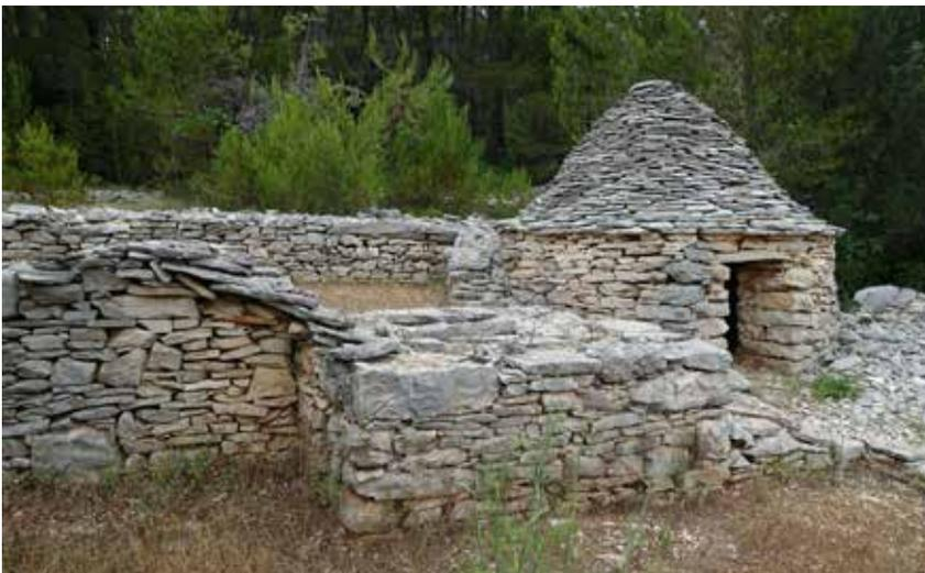
In die Mauer ist eine mit Steinplatten verschließbare **Zisterne** eingelassen, in die eine Rampe mit schräg gelegten Steinplatten das Regenwasser leitet.
