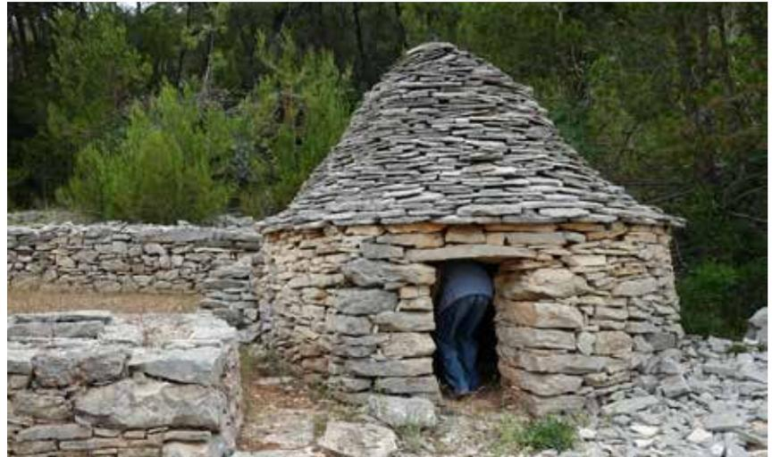
Das leicht glockenförmig geschwungene Dach erhebt sich elegant über der zylindrischen Basis. Innen mit einem runden Durchmesser von 2 m und Höhe von ca. 2,50 m relativ klein, hat die Hütte keine Einbauten wie Nischen oder Fensteröffnungen.
