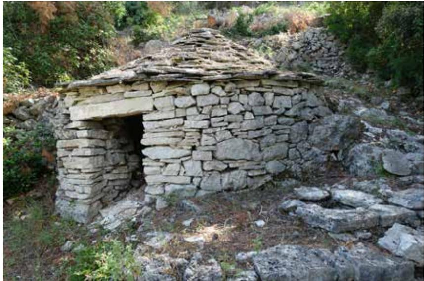
Die Hütte hat ein relativ flaches konisches Dach mit einer Steinplatte als Deckstein. Sie schmiegt sich an den Hang und im unteren Bereich sind Felsbrocken und unregelmäßige Steine mit eingebaut. Erst mit der Kuppelwölbung wurden Steinplatten verbaut, die offensichtlich bearbeitet sind. Über dem Eingang eine auffallend große Steinplatte als Türsturz.
