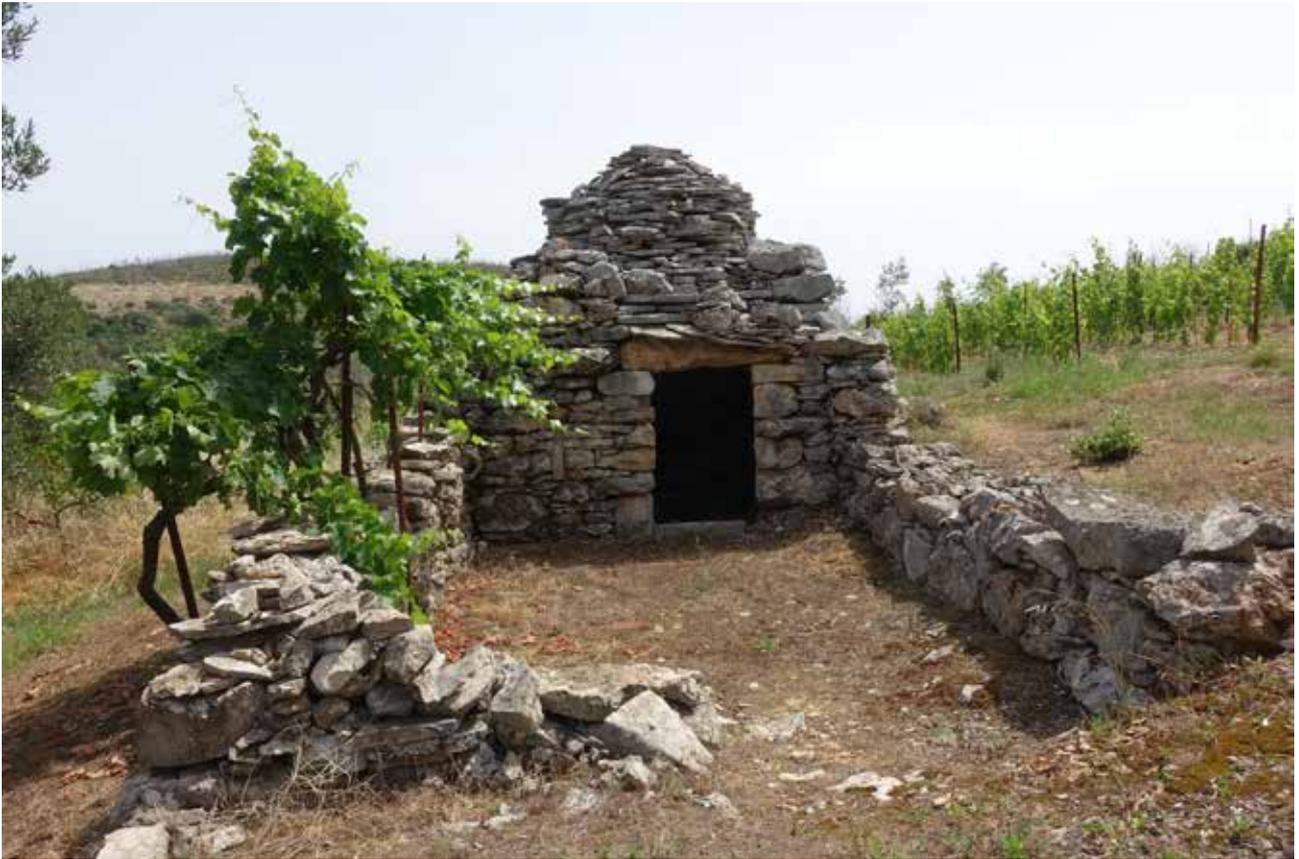
Die *toreta* ist aus unregelmäßigen Steinen geschichtet, die nur an den Ecken leicht bearbeitet sind und hat eine deutliche Stufung.
