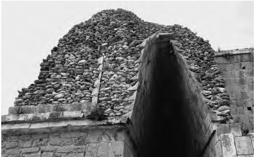
“Betonmauerwerk” gesprochen (Stierlin, Maya, S. 96). Es ist gut möglich, dass dieses aufliegende Geröll nicht ohne Bindemittel halten würde, aber sichtbar ist es nicht. Es dominiert auf jeden Fall der Eindruck, dass Mörtel nicht immer entscheidend für die Stabilität vieler Bauten ist.
