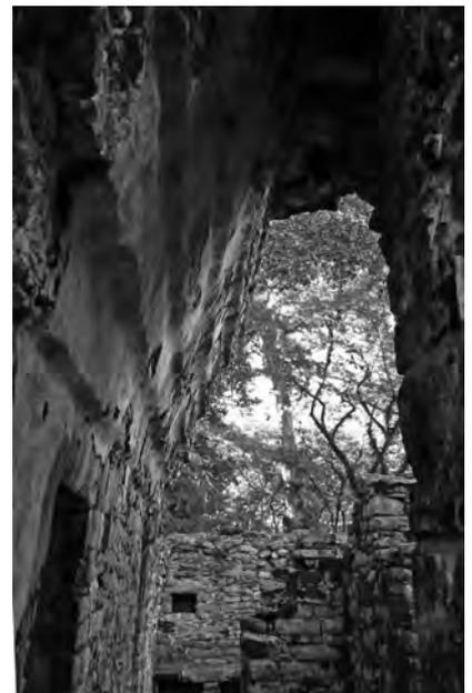
Dieses äußerlich eher unauffällige Gebäude etwas unterhalb des Königspalastes hat innen diese interessanten hohen Kraggewölbe, die durch Vorsprünge betont werden. Über den Eingängen eine gestuften Kragwölbung.
