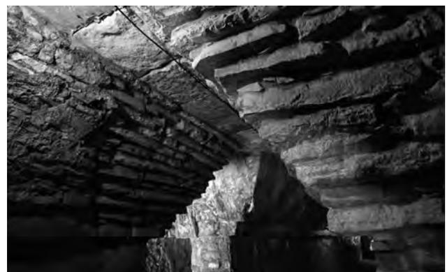
**Chichen Itza:** Die aufgetürmten Steinmassen rechts zeigen eine Ummauerung mit bearbeiteten Steinen und eine Füllung aus unregelmäßigem Material. Die Lücken wurden mit kleinen Steinen gefüllt. Mörtel ist nicht erkennbar.
