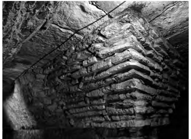
Gänge und Räume im Palast mit Kraggewölben. Die z. T. noch erhaltene Stuckschicht ist abgefallen und die stufenweise Schichtung wird sichtbar. Sie erinnert als Negativform an die Stufung der Pyramide, Foto S. 10 links oben.
