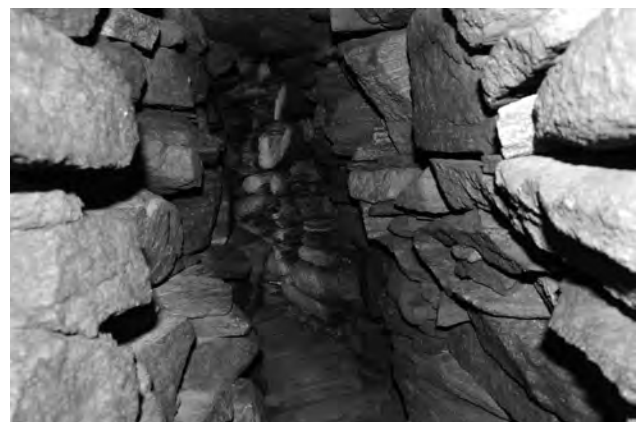
Unten: Grobe Kragkuppel in der "guard cell" in der Eingangsmauer; Gänge als Kraggewölbe
