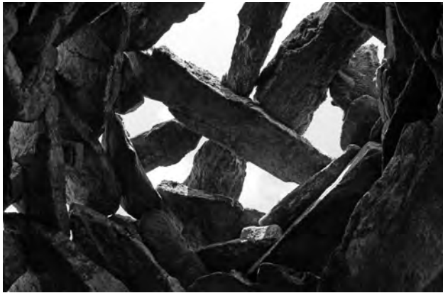
Provisorische Abdeckung mit großen Steinbalken.
